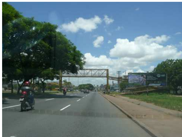
Figura 168 - Passarela situada na Avenida Hélio Prates – na região de Taguatinga.
