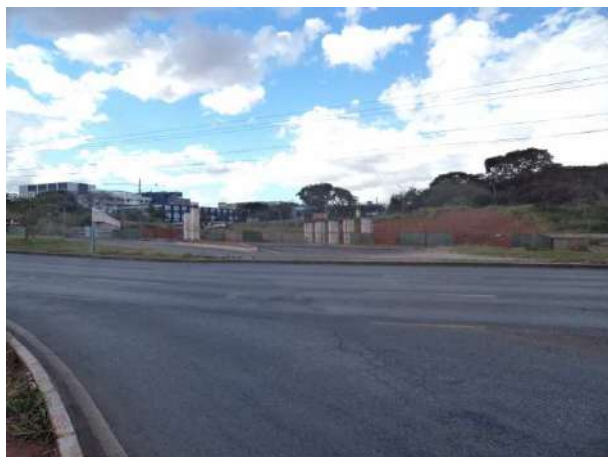
Figura 17 - Canteiro de obras da construção do Viaduto de intercessão entre ESPM e W3 Sul.
