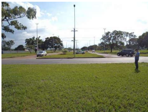
Figura 16 - Intercessão entre ESPM e via de acesso ao Setor Policial.
