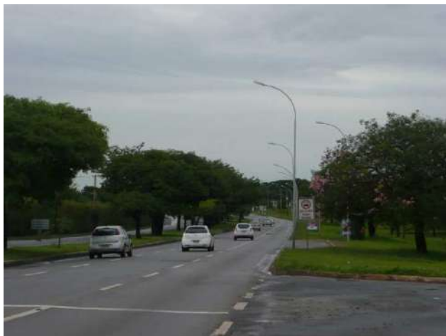
Figura 159 - Região de chegada à ESPM onde há semáforo para passagem de automóveis para órgãos de ministérios e para a Agência Nacional de Águas – ANA.
