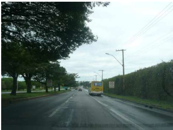
Figura 153 - Condição da via no ESPM, com duas faixas de rolagem e uma faixa exclusiva para ônibus.
