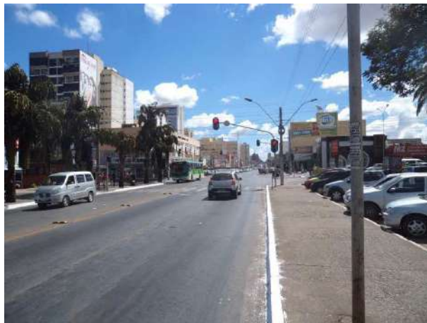
Figura 28 - Panorama da Avenida Comercial Norte.
