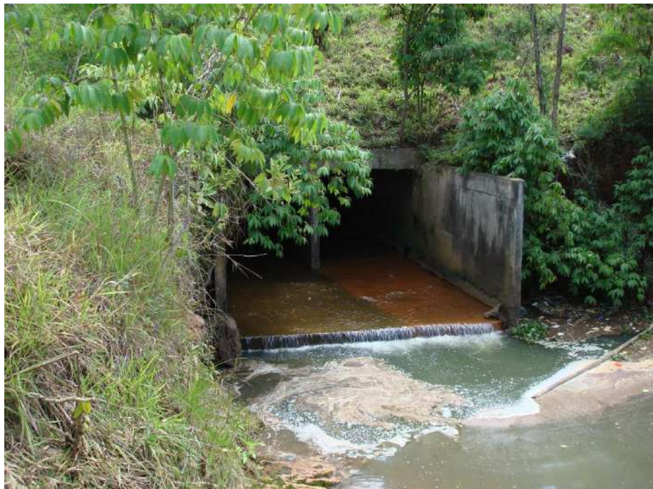
Figura 41 - Lançamento da galeria existente no Lago Paranoá.
