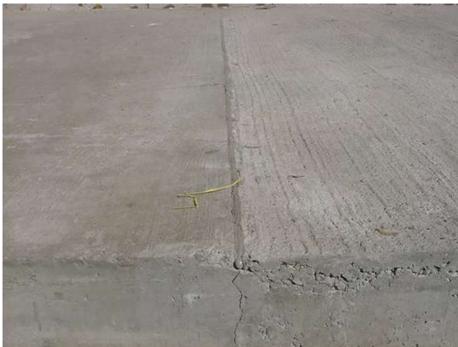
Figura 67 - Detalhe da junta transversal selada.
