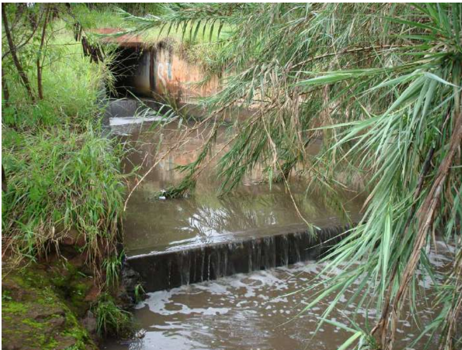
Figura 39 - Lançamento da galeria existente de 1,65x1,65m na lagoa de detenção do Parque da Cidade.
