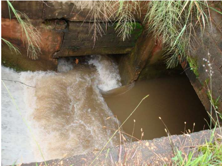
Figura 40 - Início da galeria existente 1,80x1,80m.
