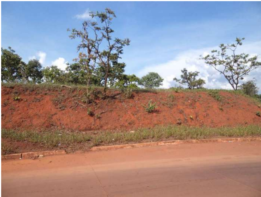
Figura 104 - Corte de solo próximo ao Terminal de Integração da Asa Sul (Perfil de Latossolo Vermelho).
