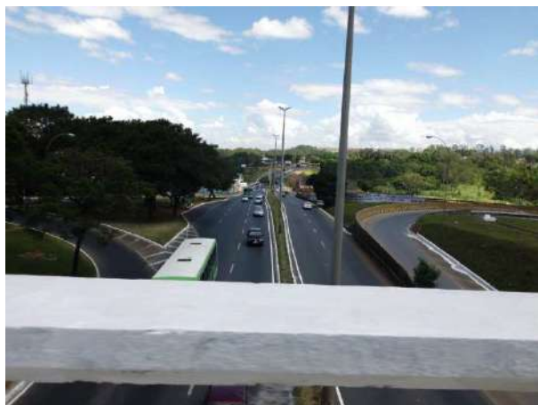
Figura 32 – Panorama da Avenida Central em ponto de intercessão com a Avenida SAMDU.
