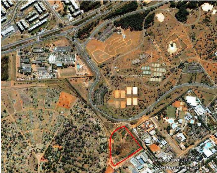
Figura 38 - Bacia de detenção Parque da Cidade.
