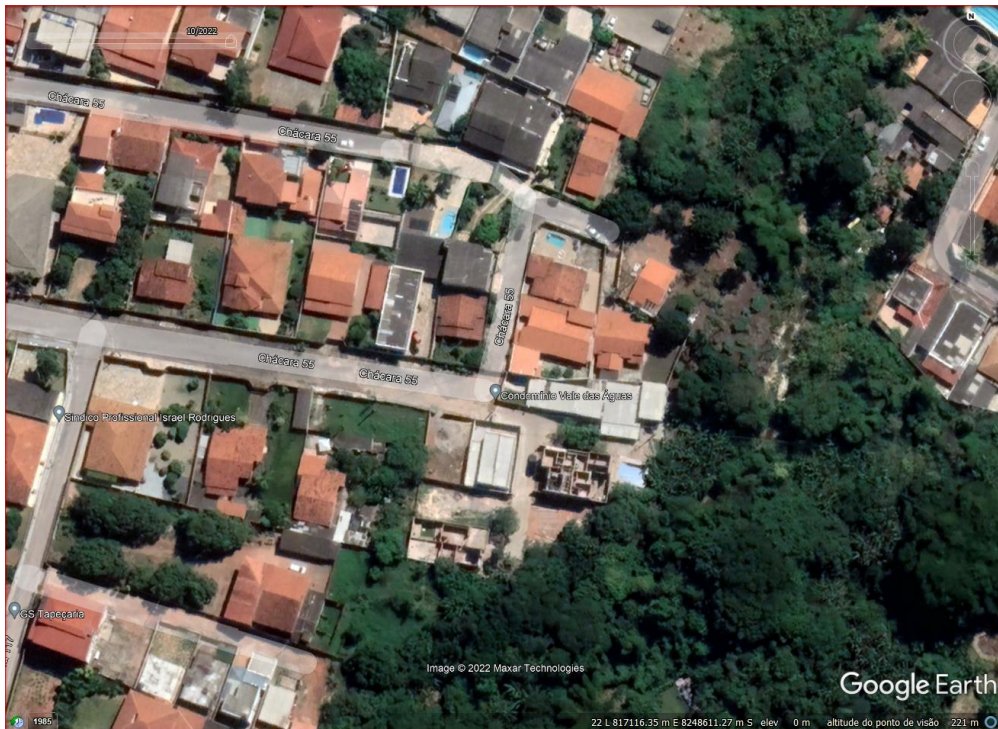
Figura 10 - Av. Misericórdia - Chácara 55 - Edificações em Out/2022
