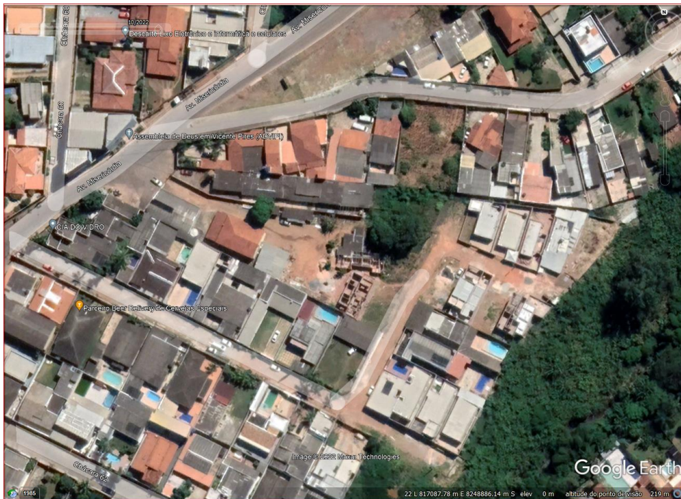
Figura 8 - Av. Misericórdia - Chácara 56 - Edificações em Out/2022
