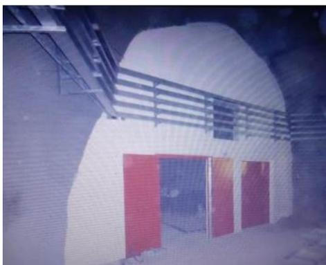
Canaletas de Cabos instaladas frontalmente à Passagem de Emergência
