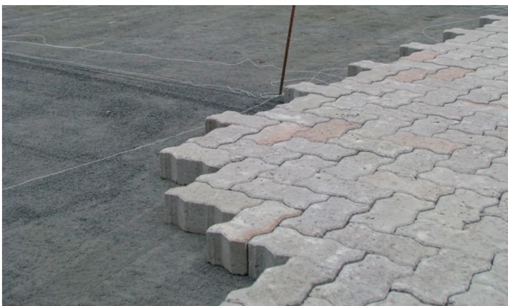
Figura 08 - Assentamento dos Bloco de Concreto (22 x 11 cm)
