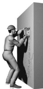
Figura 2 - Delimitação da área de reparo com disco de corte
