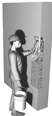
Figura 7 - Acabamento superficial com desempenadeira metálica
