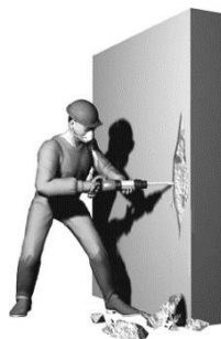
Figura 1 - Demolição superficial do concreto
