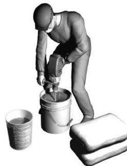
Figura 5 - Preparo da argamassa polimérica com misturador mecânico
