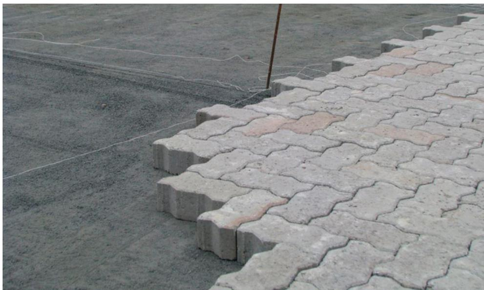
**Figura 8 - Assentamento dos Blocos de Concreto 16 Faces**
