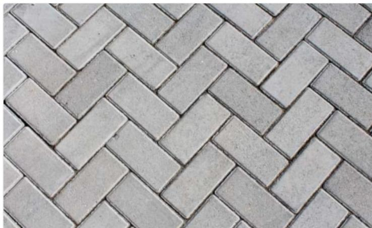
Figura 06 - Bloco retangular - Piso intertravado assentado
