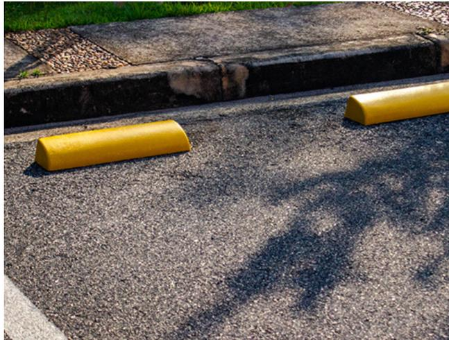
Figura 08 - Bate rodas em resina
