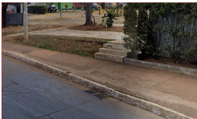
Figura 4 – Boca de Lobo com Grelha
