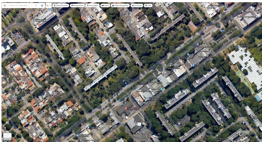
Figura 13 - Vista aérea da Via W3 Sul
