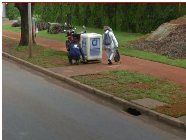
Figura 5 - Boca de Lobo com meio-fio Vazado
