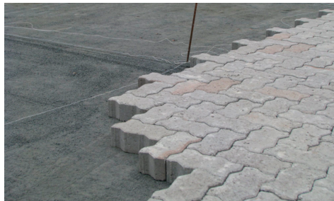
Figura 15 - Assentamento dos Blocos de Concreto.
