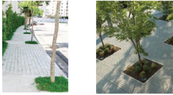
Figura 11 - Detalhe gola de árvore com moldura nivelada com o piso
