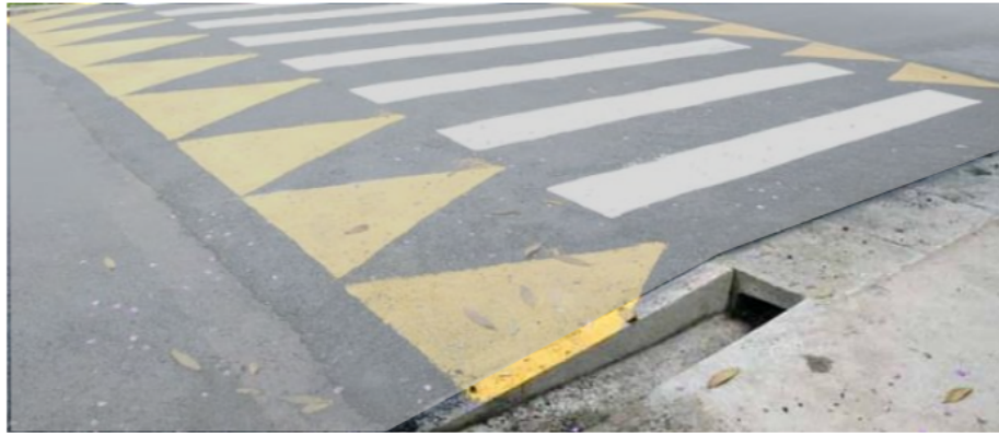
Figura 08 - Detalhe Plataforma Elevada
