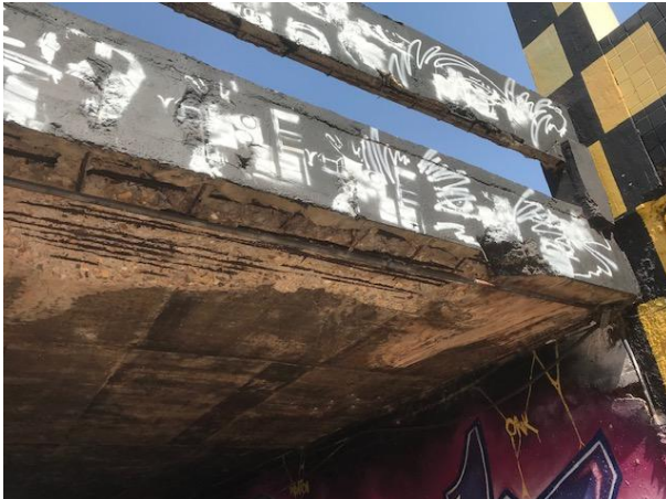
Figura 30 – Vista inferior da laje da passarela Leste
