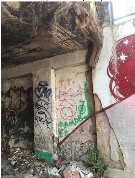
Figura 18 – Vista do pilar e da laje da passarela Oeste
