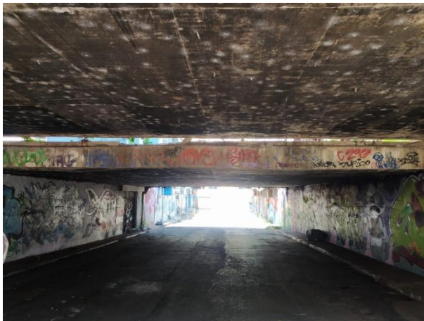
Figura 24 – Vista do encontro das lajes da passarela Oeste com a Leste
