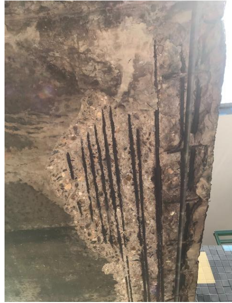
Figura 29 – Vista inferior da laje da passarela Leste
