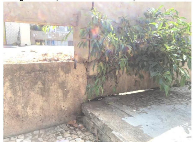
Figura 13 – Detalhe da vegetação degradando os guarda-corpos dos encontros das passarelas
