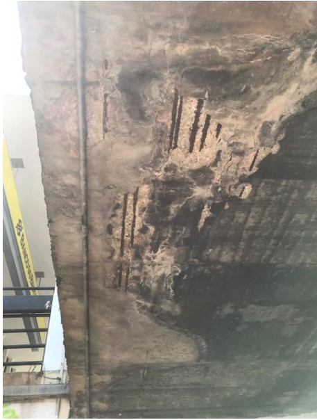
Figura 28 – Vista inferior da laje da passarela Leste
