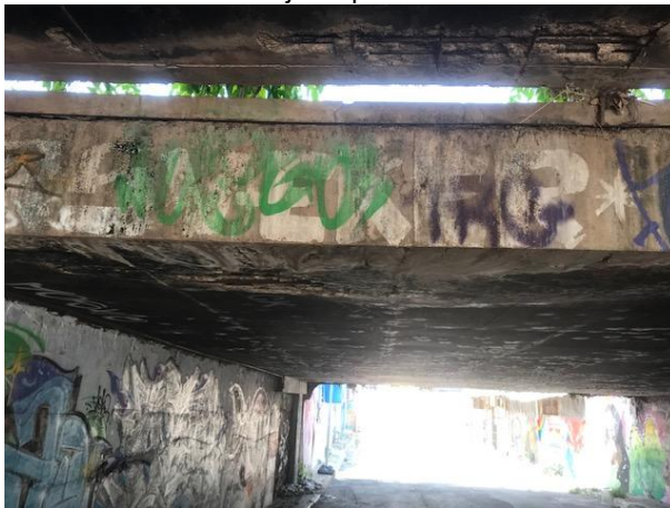
Figura 26 – Vista do encontro da laje da passarela Leste com a laje da passarela Oeste
