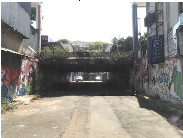
Figura 14 – Vista panorâmica da passarela sobre o Beco da Quadra 05 do SCS
