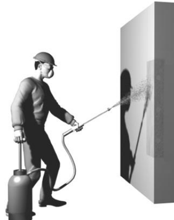
Figura 39 – Aplicação de cura sobre o reparo
