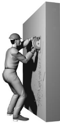
Figura 32 – Delimitação da área de reparo com disco de corte Figura 33 – Demolição superficial do concreto
