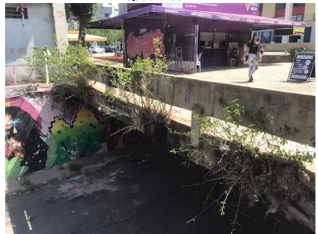
Figura 9 – Vista da passarela Oeste sobre o Beco da Quadra 05
