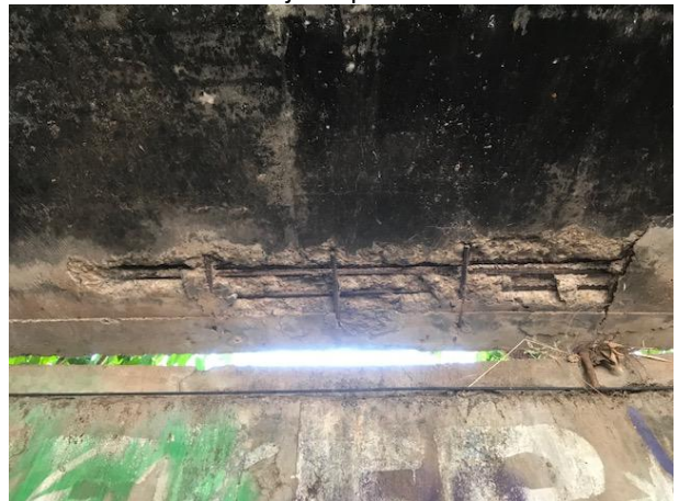
Figura 27 – Detalhe do encontro da laje da passarela Leste com a laje da passarela Oeste
