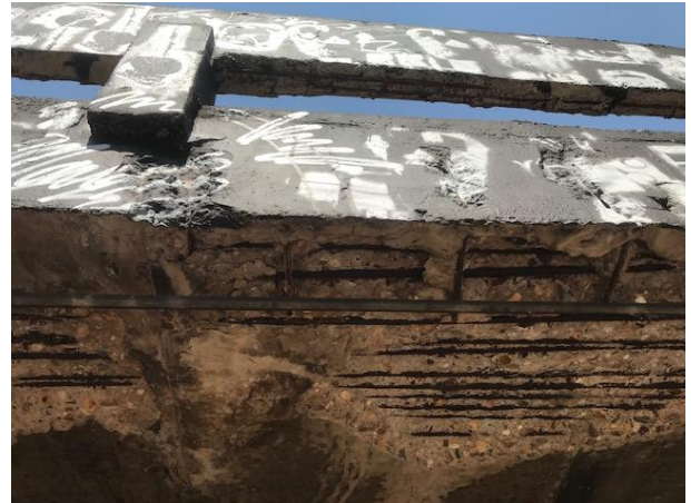
Figura 31 – Vista inferior da laje menor da passarela
