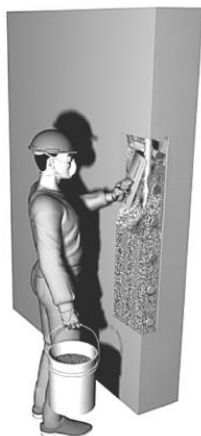
Figura 38 – Acabamento superficial com desempenadeira metálica
