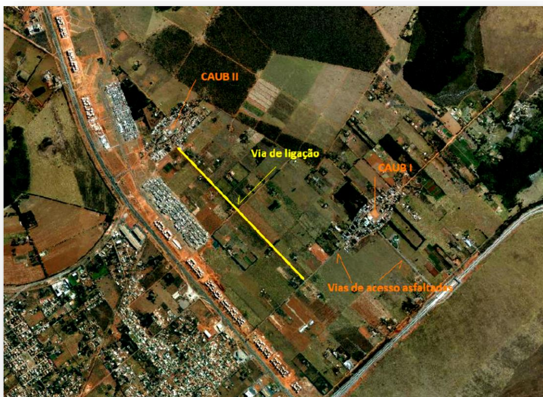
Figura 1 – Vista Geral da Área de Intervenção
