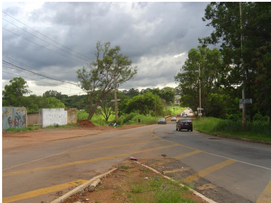
Figura 03 – Finalização do Segmento A e início do Segmento B
