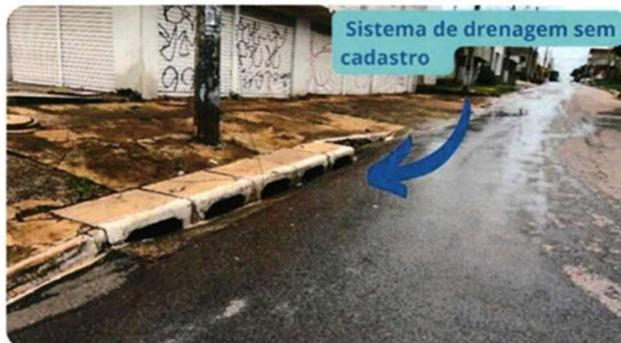
Figura 13: Dispositivos de captação de drenagem sem cadastro técnico
