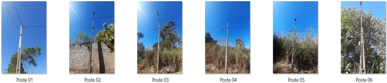
Figura 11 - Imagem dos Postes a Serem Remanejados
