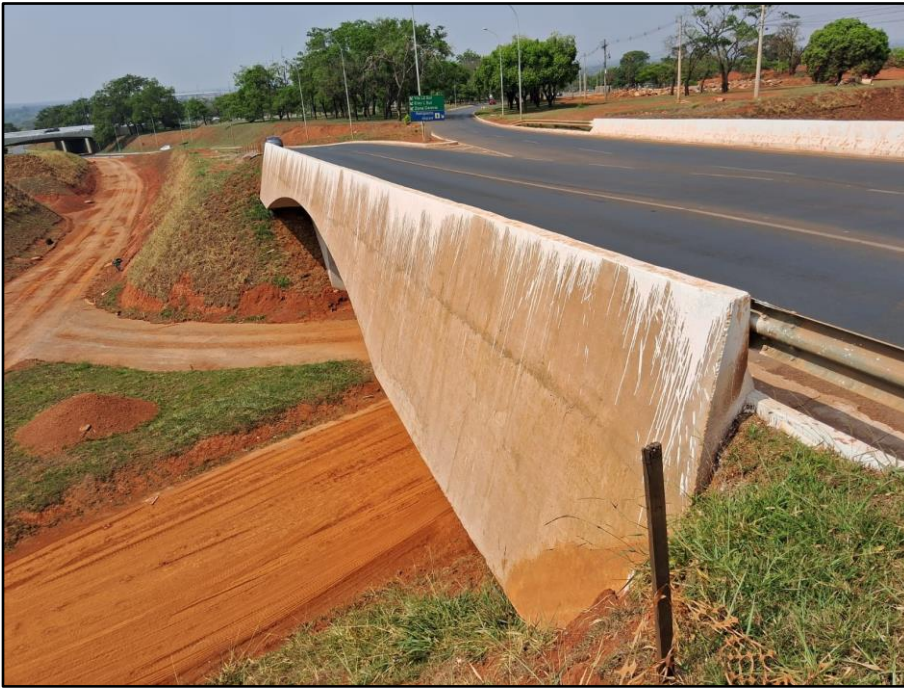
Figura 3- Vista lateral – A (OAE)
