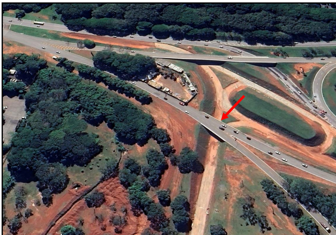
Figura 1 - Vista área do viaduto 63, fonte: Google Earth Pro em 12/10/2023
