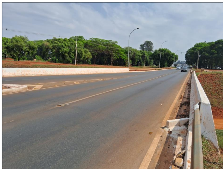
Figura 2- Vista do Viaduto
