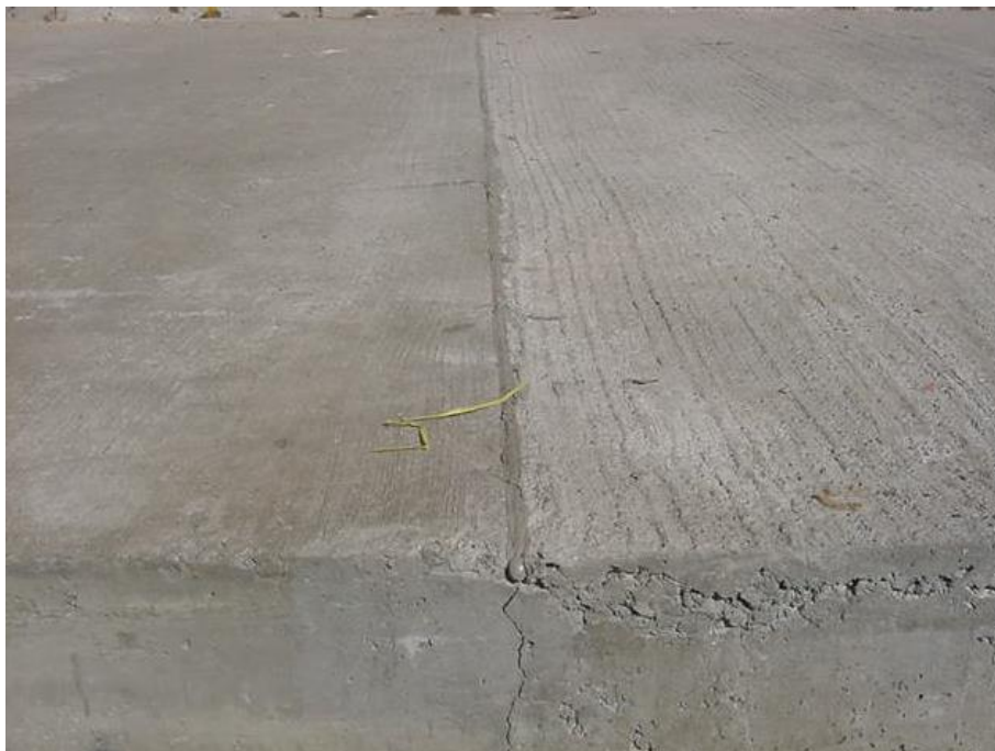
Figura 4.9 - Detalhe da junta transversal selada
