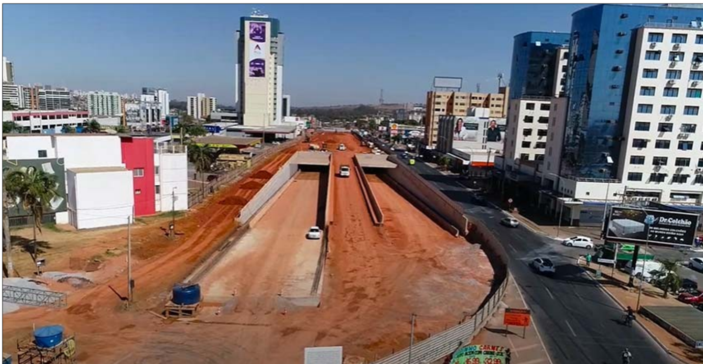
Figura 2 - Visão Geral da Obra – Sentido Brasília – Ceilândia - Fonte: Consórcio FutureATP- Prisma
