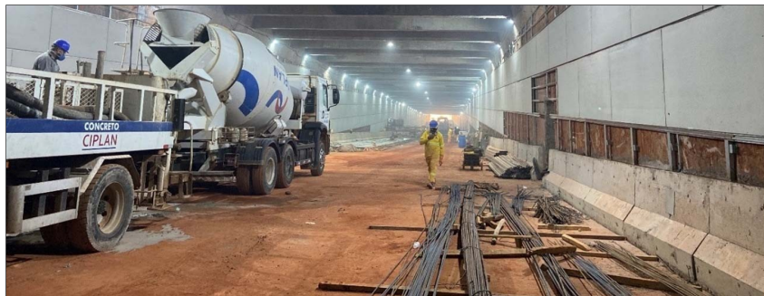
Figura 6 - Fase 2 – Túnel Sul – Em execução - Fonte: Consórcio FutureATP-Prisma
