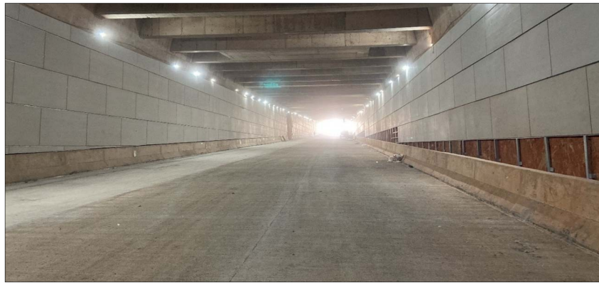
Figura 5 – Fase 1 – Túnel Sul – Com pavimentação rígida em conclusão - Fonte: Consórcio FutureATP-Prisma
