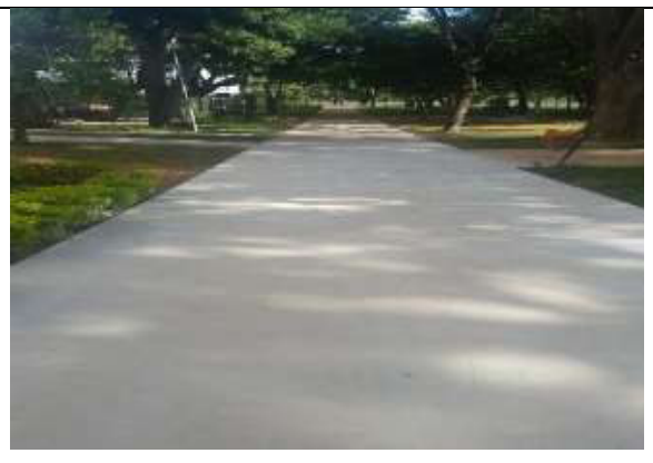
Execução de Calçadas na SQS 109
