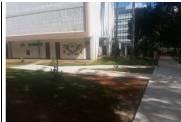
Execução de Calçadas na SQS 107
