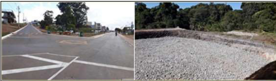
Urbanização em Vicente Pires (CT.: 010/2015)
