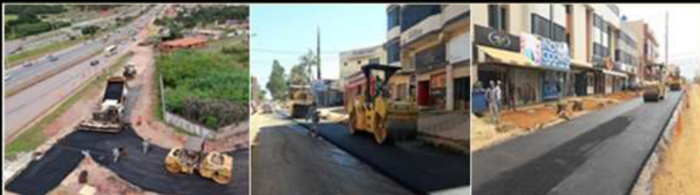
Execução de CBUQ, Marginal EPTG
