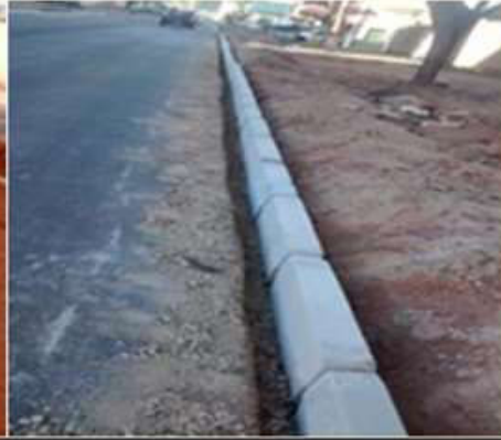
Execução meios-fios Rua 05
