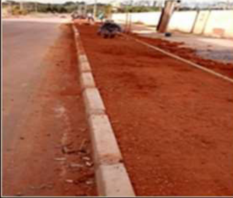
Execução de meios-fios Rua 4C
