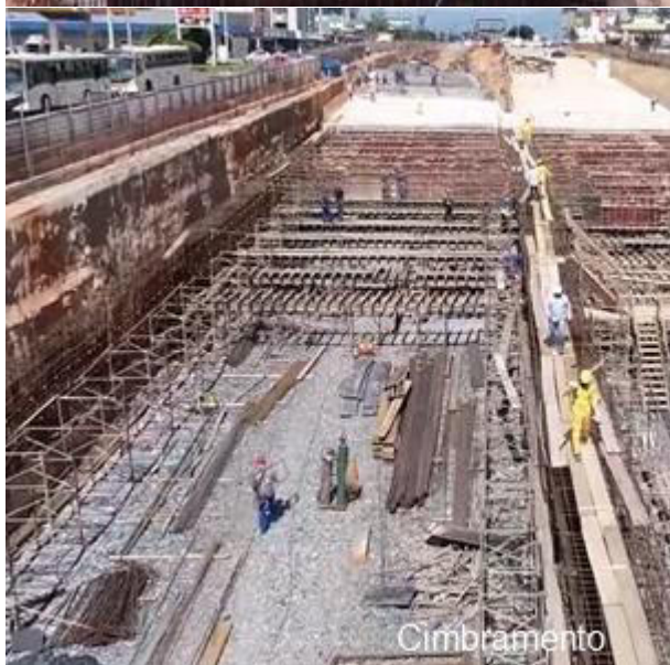
Execução de formas da laje de topo
