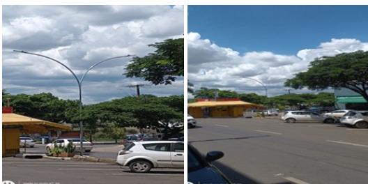
Implantação de Iluminação Pública na Via NB-01 - Núcleo Bandeirante
