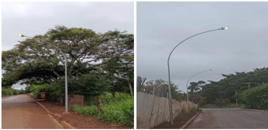
Implantação de Iluminação Pública na Rua Primavera - Ponte Alta
