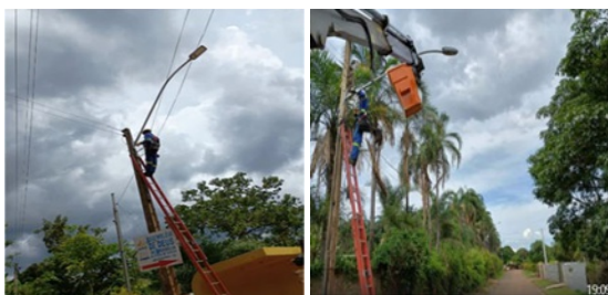
Implantação de iluminação pública no Núcleo Rural Olhos D'Água - Gama - Emenda Parlamentar - Obra Concluída em 30/12/2024
