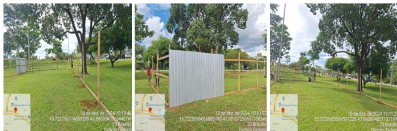
Contrato nº 9/2024 - Restauração/recuperação de pavimento
