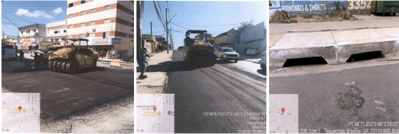
Contrato nº 21/2016 - Infraestrutura no Vicente Pires
