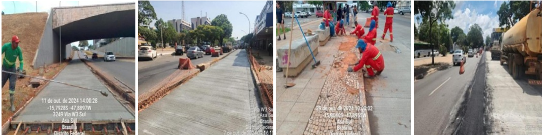
Contrato nº 16/2022 - Restaurar pavimento da Avenida W3 Sul
