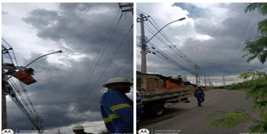
Implantação de Iluminação Pública no Viaduto sobre a EPIA Sul, Candangolândia
