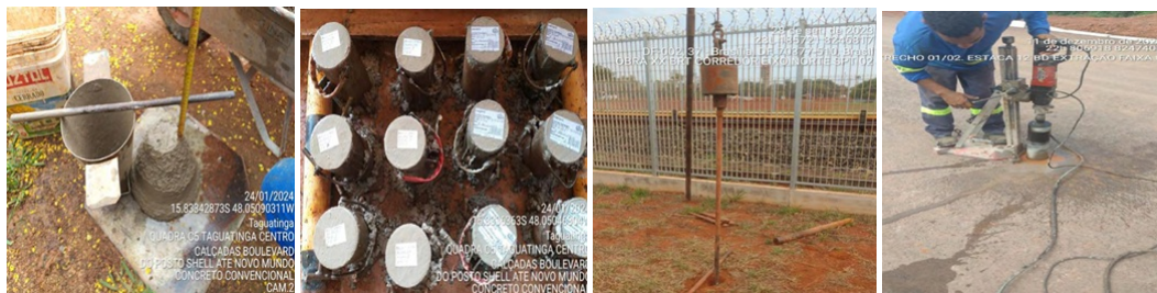
Contrato nº 8/2023 - Realizar serviços geotécnicos/geológicos (Lote 1) e de controle tecnológico laboratorial (Lote 2)
