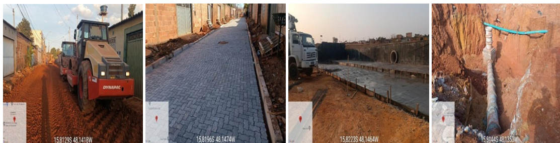
Contrato nº 23/2022 - Infraestrutura no Sol Nascente Trecho 3 - Lote 2
