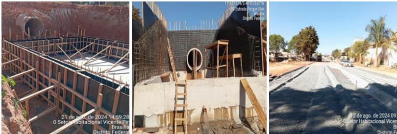
Contrato nº 19/2021 - Infraestrutura no Vicente Pires
