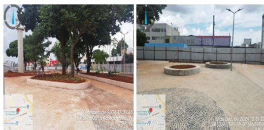
Contrato nº 31/2023 - Requalificação da Praça do Relógio
