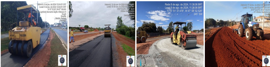
Contrato nº 23/2023 - Duplicação da via Guará - Núcleo Bandeirante (Subtrecho entre a Av. Contorno do Guara II e a DF- 079)
