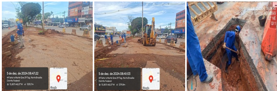
Contrato nº 9/2022 - Requalificação da Avenida Hélio Prates , Etapa 2
