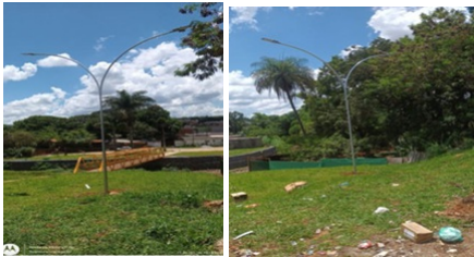
Implantação de iluminação pública na Vila Cauhy
