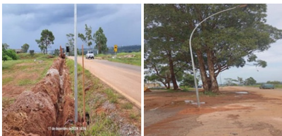
Implantação de rede de Iluminação Pública no Núcleo Rural Monjolo
