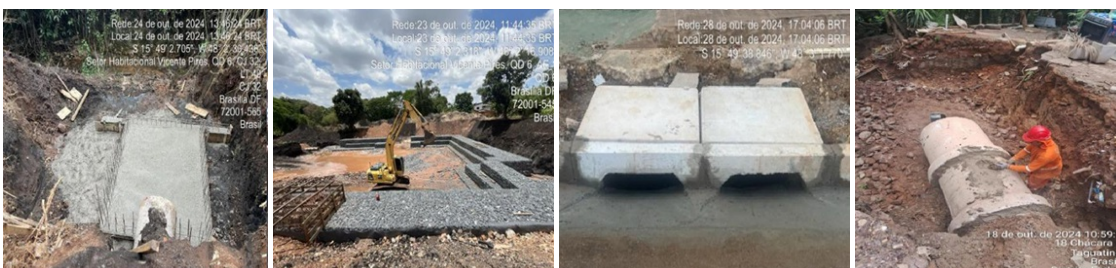
Contrato nº 29/2023 - Infraestrutura no Vicente Pires
